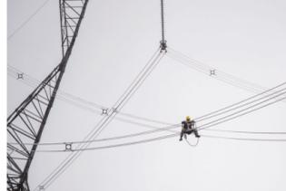
昨日，国网重庆市送变电公司的技术人员在海拔1500米的高山上，沿着高空500千伏张隆线进行走线验收。
