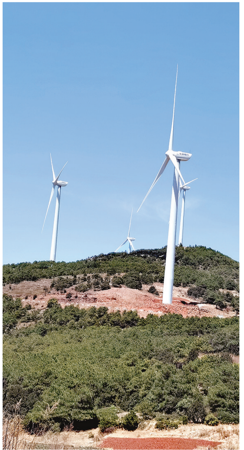
剑川县金华风电场一角。(摄于4月15日) 近年来，剑川县立足能源资源禀赋和发展特点，稳步推进新能源开发，先后建成金华、甸南、百山母、雪邦山、金公山5个风电场，实现装机23.1万千瓦，推动了全县绿色能源高质量发展。 [通讯员 高文 摄]
