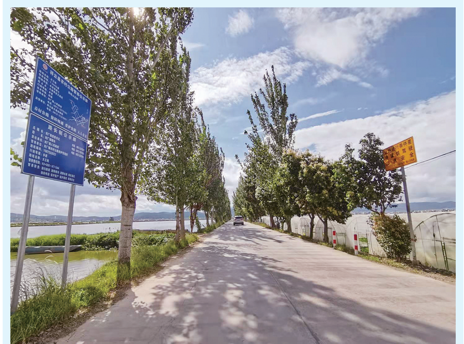
祥云县刘厂镇“四好农村路”让农村更强、农民更富、乡村更美。(摄于9月6日) 近年来,刘厂镇坚持“规划、建设、管理、疏导”多措并举,着力建好、管好、护好、运营好农村公路,目前,全镇行政村及村民小组主干道硬化率达100%,创建“四好农村路”4条、村级“示范路”8条,同时在全镇范围内全面建立“路长制”,通过定人、定岗、定责的管护模式实现道路“整洁、规范、美观、文明、有序”,全面提升道路交通文明形象,为广大农民致富奔小康、加快推进农业农村现代化提供更好保障。 [通讯员 杨雪鹤 摄]
