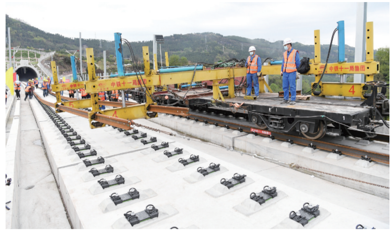
昨日, BCLP500型本邻两线长轨铺设机组进行机械化跨线铺轨作业。记者从渝万铁路有限责任公司获悉, 3月17日, “走单线铺双线”的施工技术在郑万高铁重庆段铺轨作业现场正式投入运用。这一技术填补了我国高铁机械化跨线铺轨作业技术空白。据了解, 这次郑万高铁重庆段铺轨, 首次运用了BCLP500型本邻两线长轨铺设机组, 铺轨准备时间减少约50%, 大幅提升了铺轨作业效率。【新华社记者 唐奕 摄】
