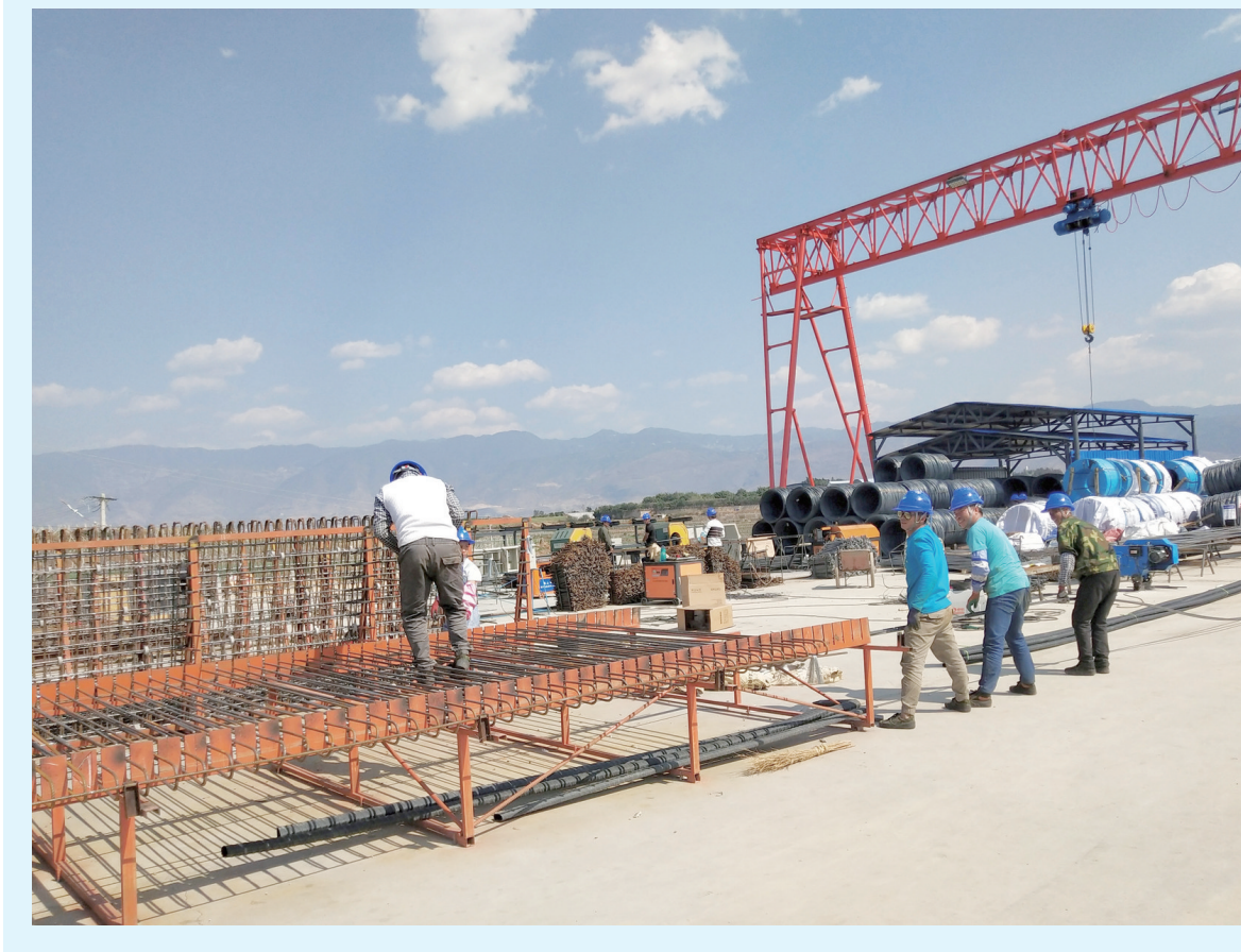
施工人员在宾南高速宾川段二工区梁板预制场施工点作业。(摄于2月18日) 近年来,宾川县大力推进高速公路建设,促进县域经济发展。目前,大永高速已建成通车,宾南高速宾川段、宾鹤高速宾川段建设正稳步推进。2020年,宾川县共完成投资190342万元。 [通讯员 张义红 杨进礼 摄影报道]
