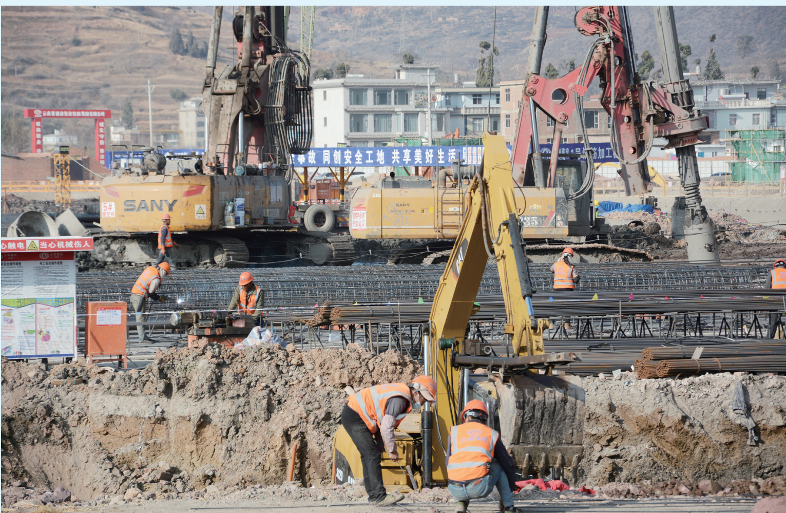
1月13日,滇西区域医疗中心建设项目正在加紧施工。
