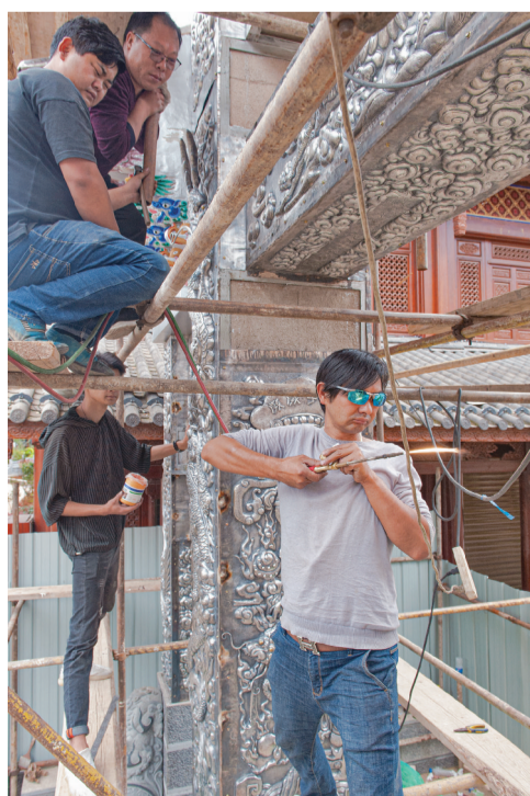
9月27日,银牌坊进行安装焊接情景。
