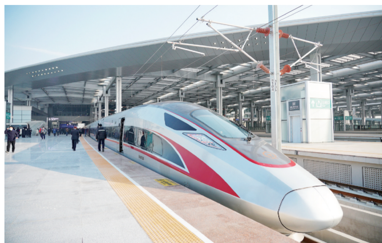
昨日，从雄安开往北京西的首发列车停靠在雄安站站台。当日，北京至雄安新区城际铁路大兴机场至雄安新区段开通运营，京雄城际铁路实现全线贯通，雄安站同步投入使用。 [新华社记者 牟宇 摄]
