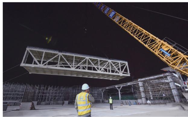
在杭绍台铁路浙江温岭站房工地,履带式起重机在进行天桥整体吊装作业(12月1日摄)。
