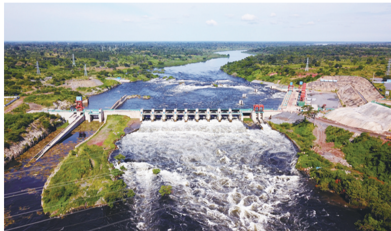
这是7月11日在乌干达基里扬东戈航拍的卡鲁马水电站项目。由中国水电承建的卡鲁马水电站是乌干达在建的最大水电站,项目总投资约17亿美元,设计装机容量60万千瓦。
