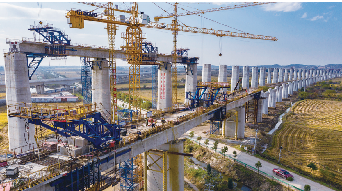
昨日,在湖北省黄梅县境内拍摄的中铁十一局黄黄高铁港特大桥连续梁浇筑现场(无人机照片)。
