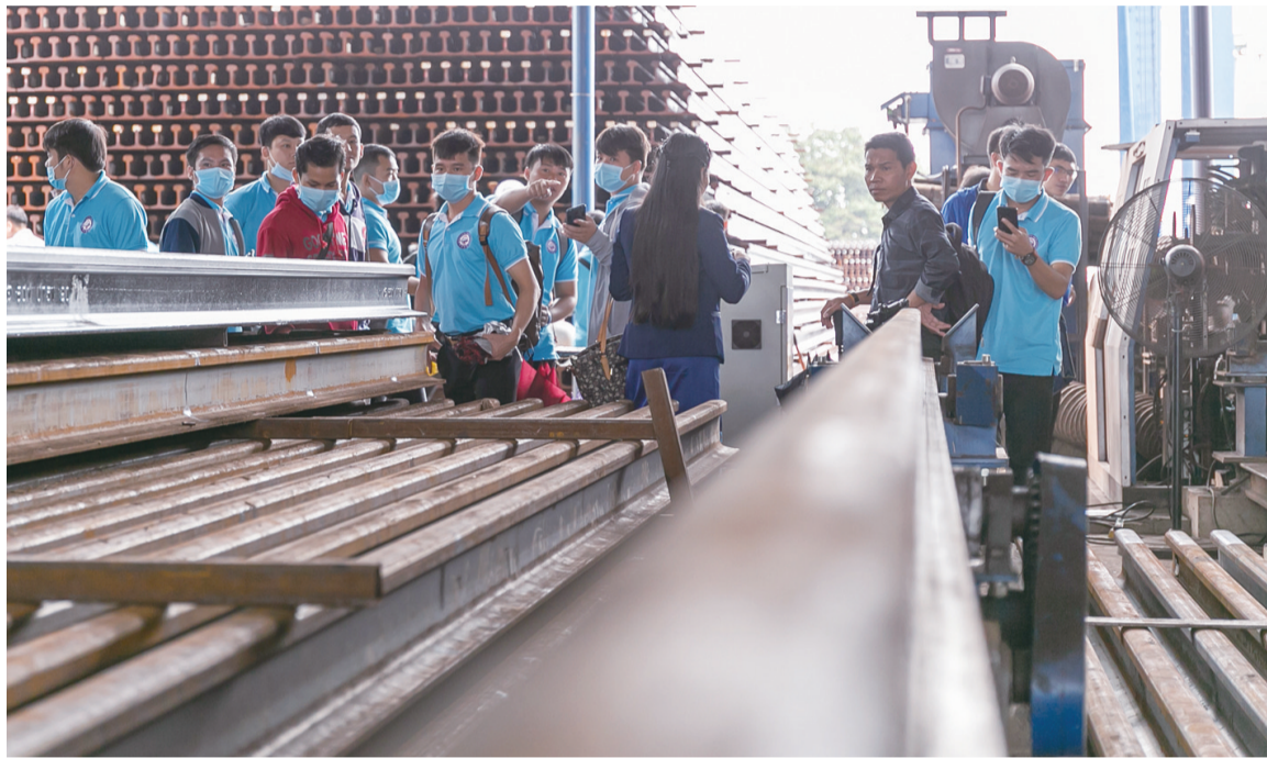
9月11日，老挝学员参观中铁二局中老铁路万象铺轨基地。当日，中老铁路运营期老挝籍学员代表约70人在中老铁路有限公司的组织下参观了中铁二局中老铁路万象铺轨基地，并乘坐工程列车体验已完成铺轨作业的铁路区段。
