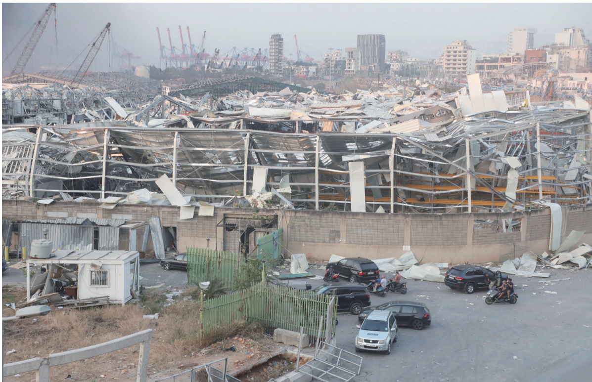
8月4日,黎巴嫩首都贝鲁特港口区发生爆炸后建筑物受损。
