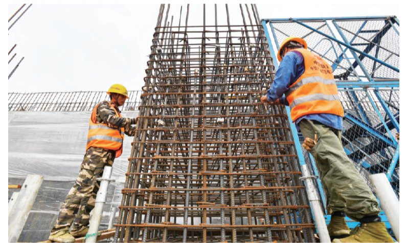
昨日,中铁十一局工人在清远磁浮银盏温泉站施工。目前,广东首条中低速磁浮线——清远磁浮旅游专线项目建设有序推进。广东清远磁浮旅游专线项目全长约38公里,预计在2020年底实现主体工程全面完工。 [新华社记者 刘大伟 摄]
