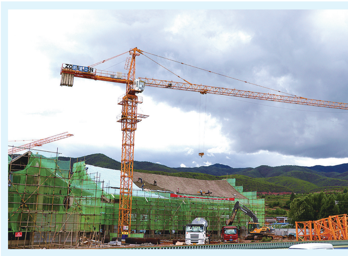
剑川县沙漠特色小镇旅游集散中心正在如火如荼建设中。(摄于7月15日)
