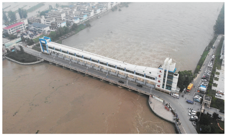
7月20日，洪水通过王家坝闸涌入蒙洼蓄洪区（无人机照片）。 当日8时32分，淮河干流王家坝闸开闸泄洪。受近期强降雨影响，淮河干流王家坝站水位19日快速上涨，7月20日6时36分水位涨至29.66米，超过保证水位0.36米。淮河王家坝闸开闸泄洪，蒙洼蓄洪区启用。 【新华社记者 黄博涵 摄】
