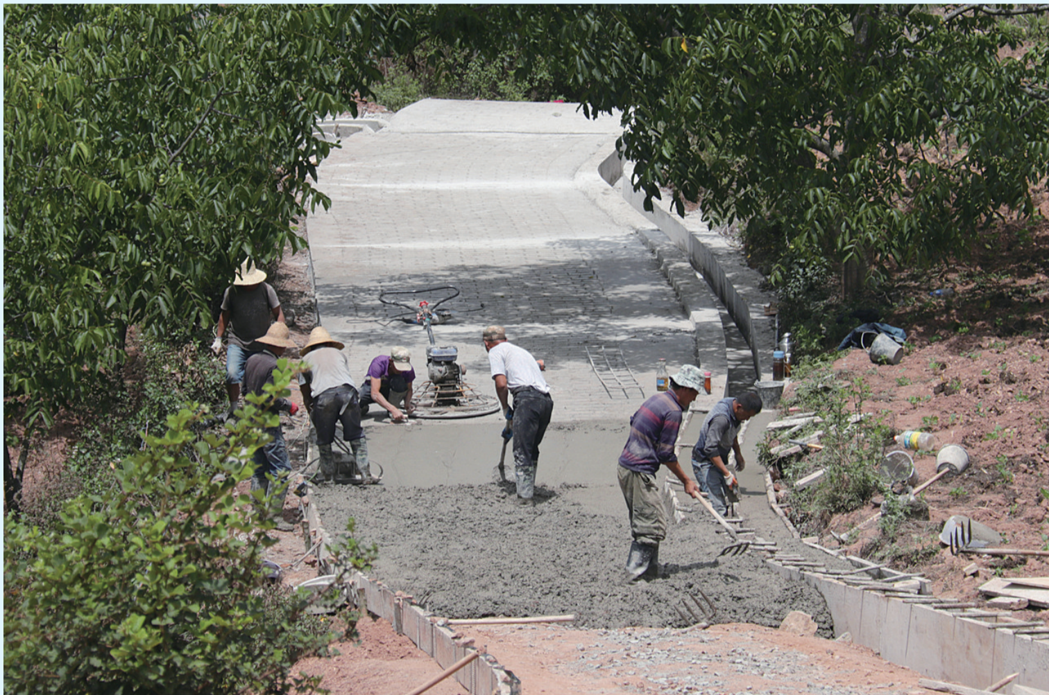
施工人员在实施硬化村组公路项目。(摄于6月29日)
