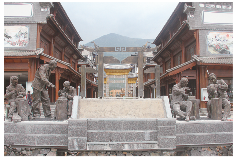
正在建设中的鹤庆新华银器艺术小镇水景观工程。(摄于11月5日) 随着鹤庆新华银器艺术小镇银器文化交流中心一期项目的建设完成，新华银匠村建设初具规模。鹤庆银城公司不断做强、做大新华银器艺术小镇文化和旅游产业，引领更多的村民就业和发家致富。
