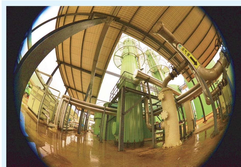
正在进行安装调试的顺丰洱海环保科技股份有限公司生物天然气工程脱硫设备。(6月3日报)
