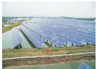
昨日,工作人员在巡查刚刚并网运行的潮州市南浔区和镇渔光互补发电站。该发电项目装机容量100兆瓦,预计每年上网电量1.5亿千瓦时,可节约标准煤3.5万吨,减少二氧化碳排放9.2万吨。
